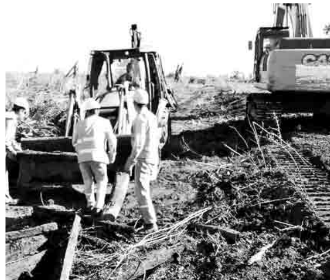
Con los trabajos, se potenciará la red ferroviaria del Belgrano Cargas, que une el norte argentino. FOTOS GENTILEZA
